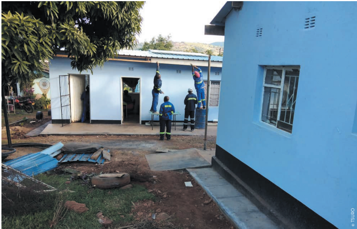
A la clinique Ngorima au Zimbabwe, les toits ont été remplacés et l'intérieur entièrement rénové.
